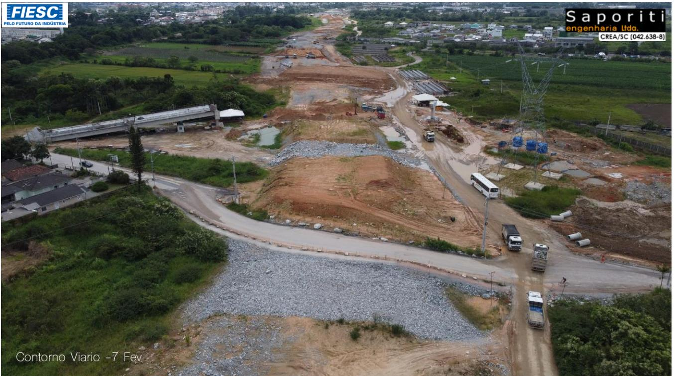
**36:** Passagem em desnível, em execução, bem como aterro sobre carga, para adensamento ...
