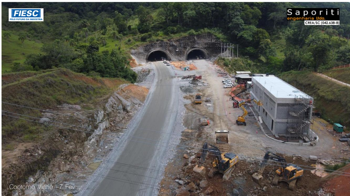
**27:** Execução da Casa de Equipamentos do túnel 03. As obras de drenagens e pavimentação do túnel executadas. Iluminações e ventilações internas, em execuções.
