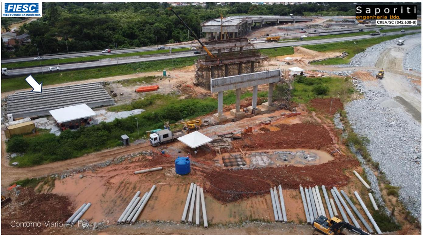
**41:** Trevo com a BR-101 (Sul) ... Estimado em 66 % executado. Vide vigas pré-fabricadas
