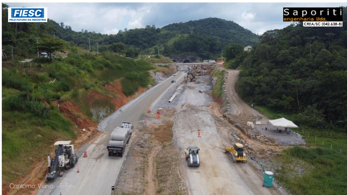
**25:** Ao fundo o túnel 03 (Sul), e obras de pavimentação em execução ... km. 42,0 VC
