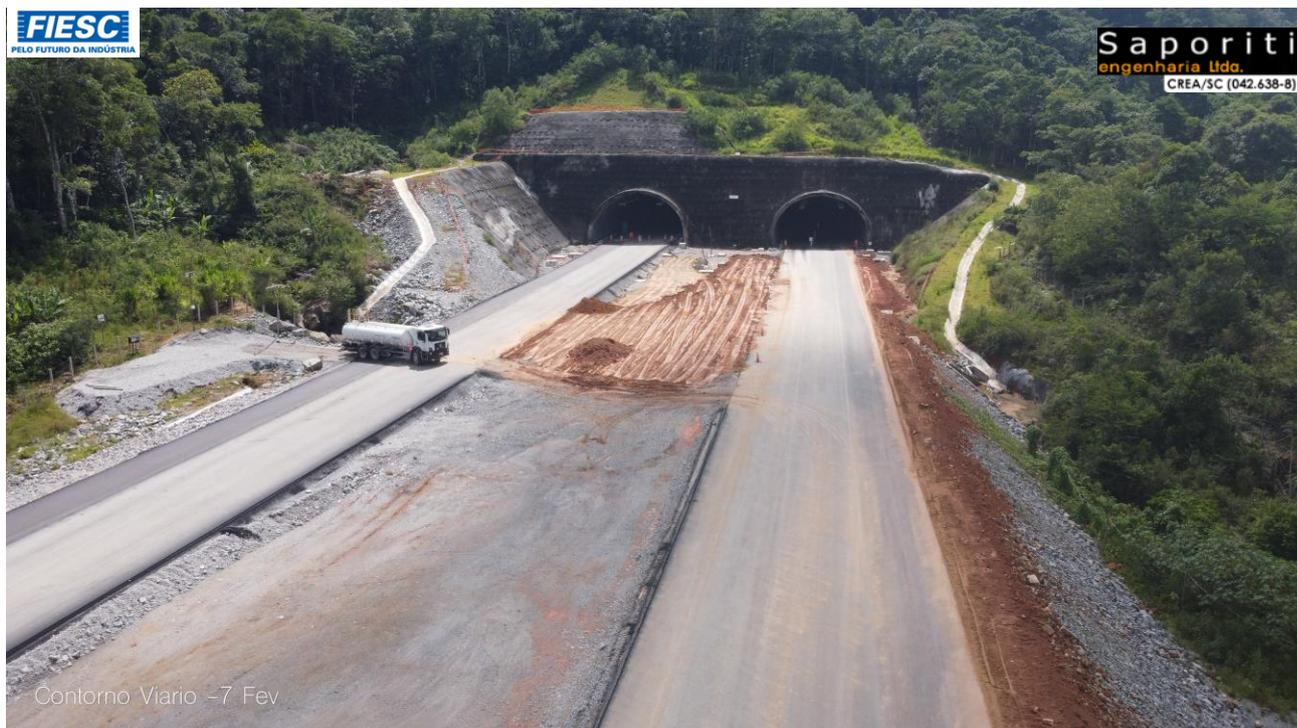
**21:** Túnel 04 - Sistemas de drenagens e pavimentações concluídas. Concluindo instalações elétricas e ventilações.
