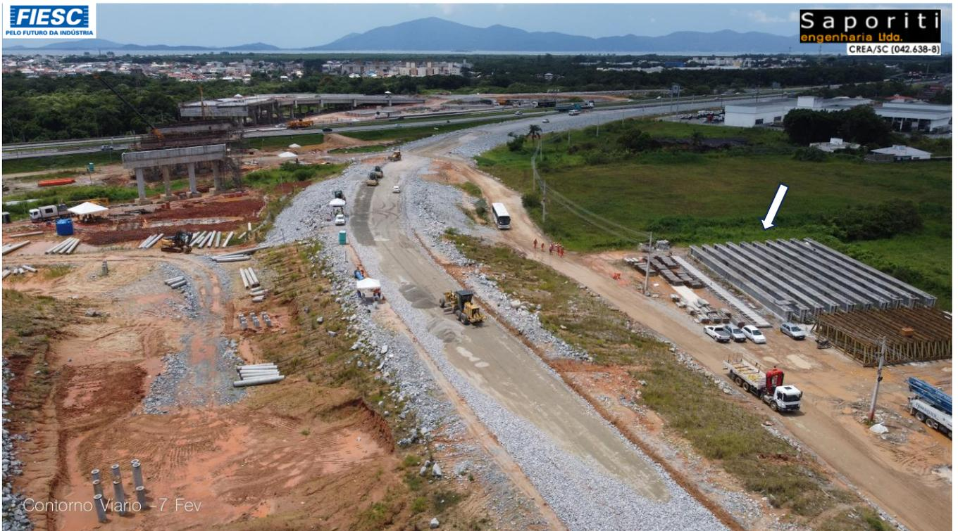
**40:** Preparando base para pavimentação de uma das alças de acesso a BR-101- Sul. Vigas pré-fabricadas prontas.
