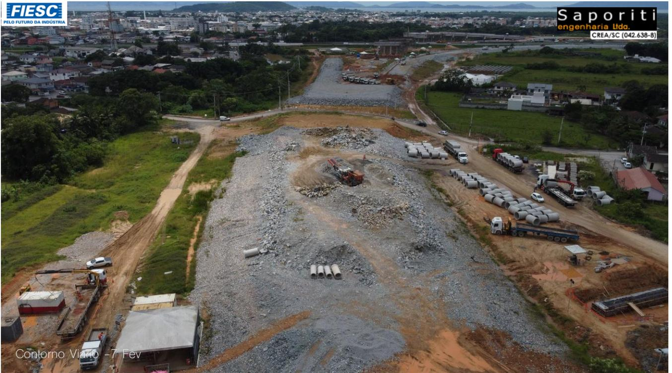
**38:** Ao fundo entroncamento c/ a BR- 101 (Sul). Preparando base p/pavimentação - km 46,3 CV
