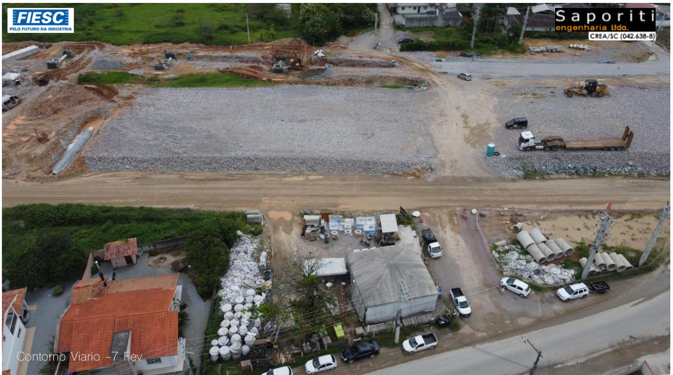
**31:** Execução da sub-base e base da pavimentação do segmento ... km. 43,8 CV
