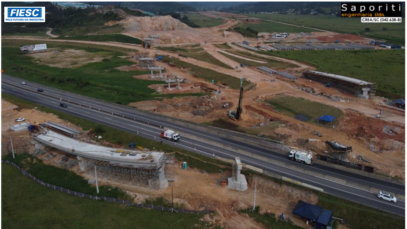
1: COMPLEXO DA INTERSEÇÃO VIA DE CONTORNO COM A BR-101 NORTE NO KM 176+000 Execução de serviços de terraplenagem, drenagens e obras de artes especiais (viadutos)
