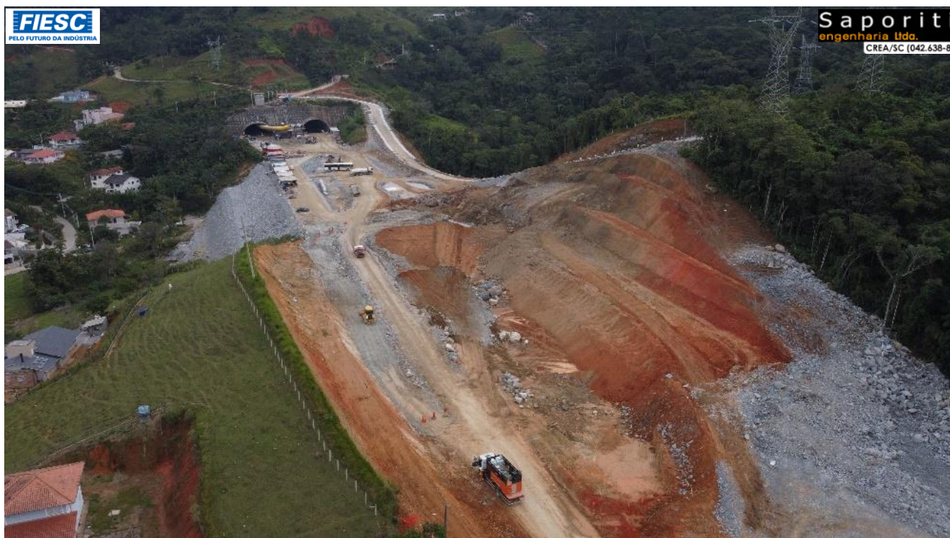
15: TERRAPLENAGEM EM EXECUÇÃO NO KM 222+450 Atividades de implantação e pavimentação em andamento no eixo tronco
