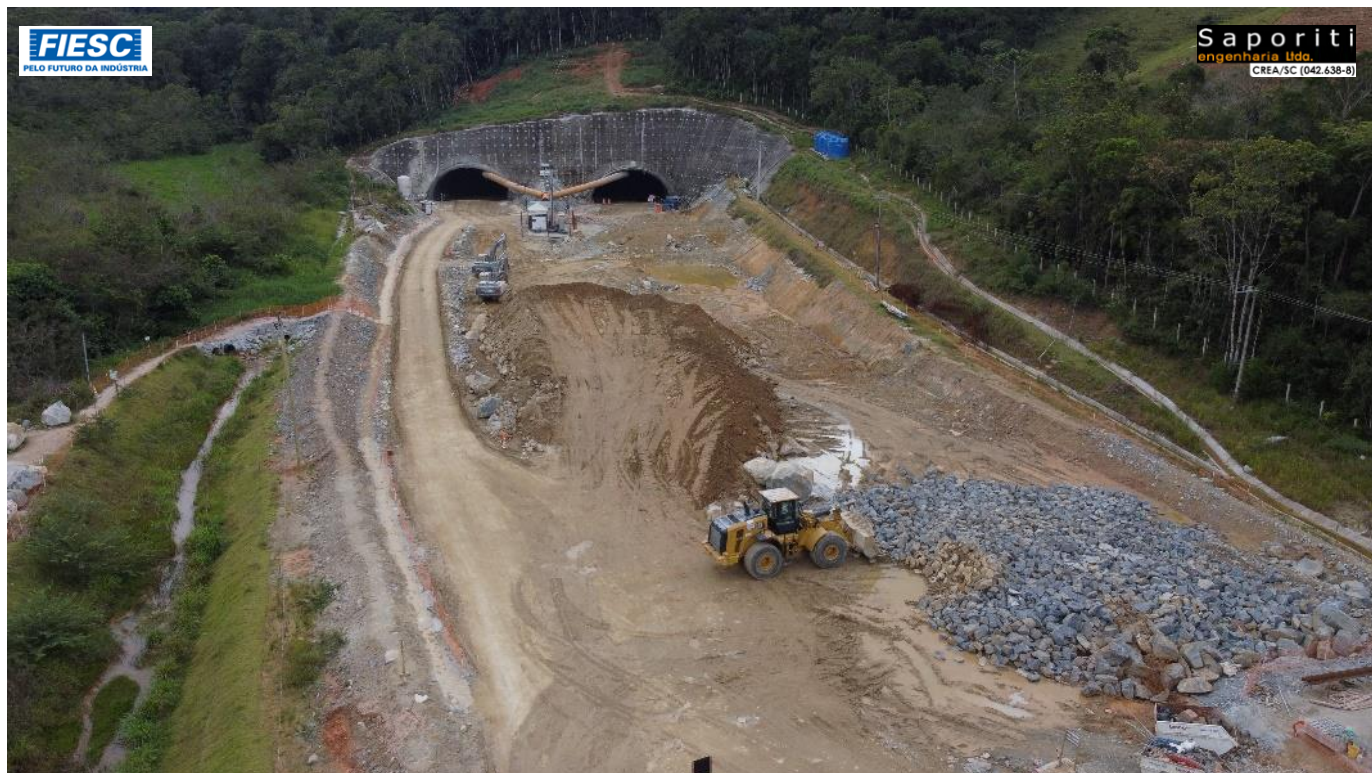
21: TÚNEL 03 - EMBOQUE SUL NO KM 226+365 – Obras de terraplenagem, em execuções, no segmento entre o túnel 03 (Sul) e o entroncamento com a BR-282/SC
