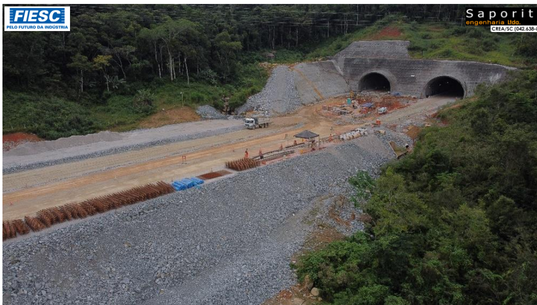
14: EMBOCAMENTO SUL DO TÚNEL 01 NO KM 221+748 Frentes de trabalhos das duas pistas com escavações concluídas
