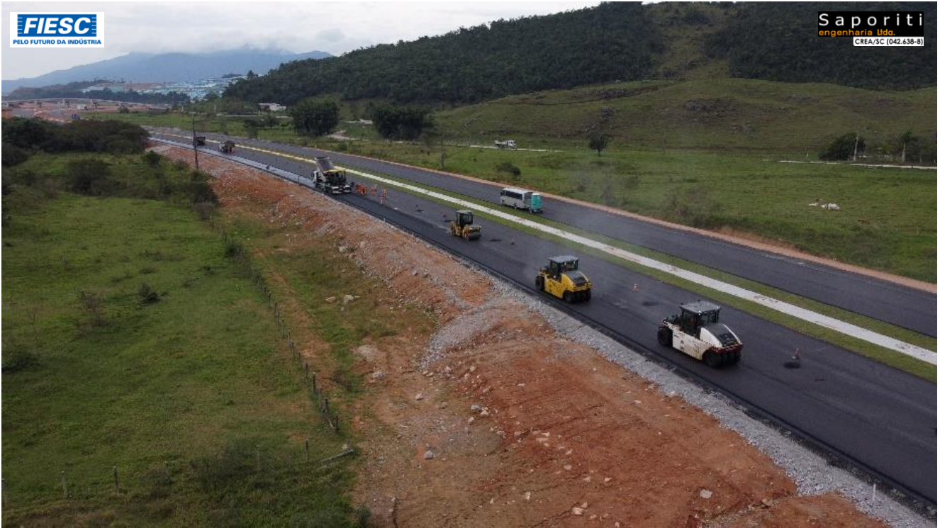
5: PAVIMENTAÇÃO EM EXECUÇÃO NO KM 179 + 300
