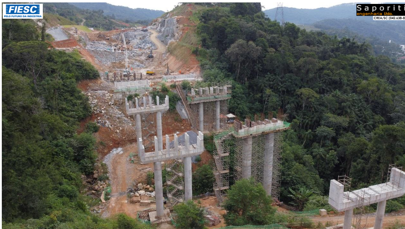
18: MESOESTRUTURA DO VIADUTO DE ACESSO AO TÚNEL 03 NO KM 225+163 Magnífica obra de engenharia rodoviária
