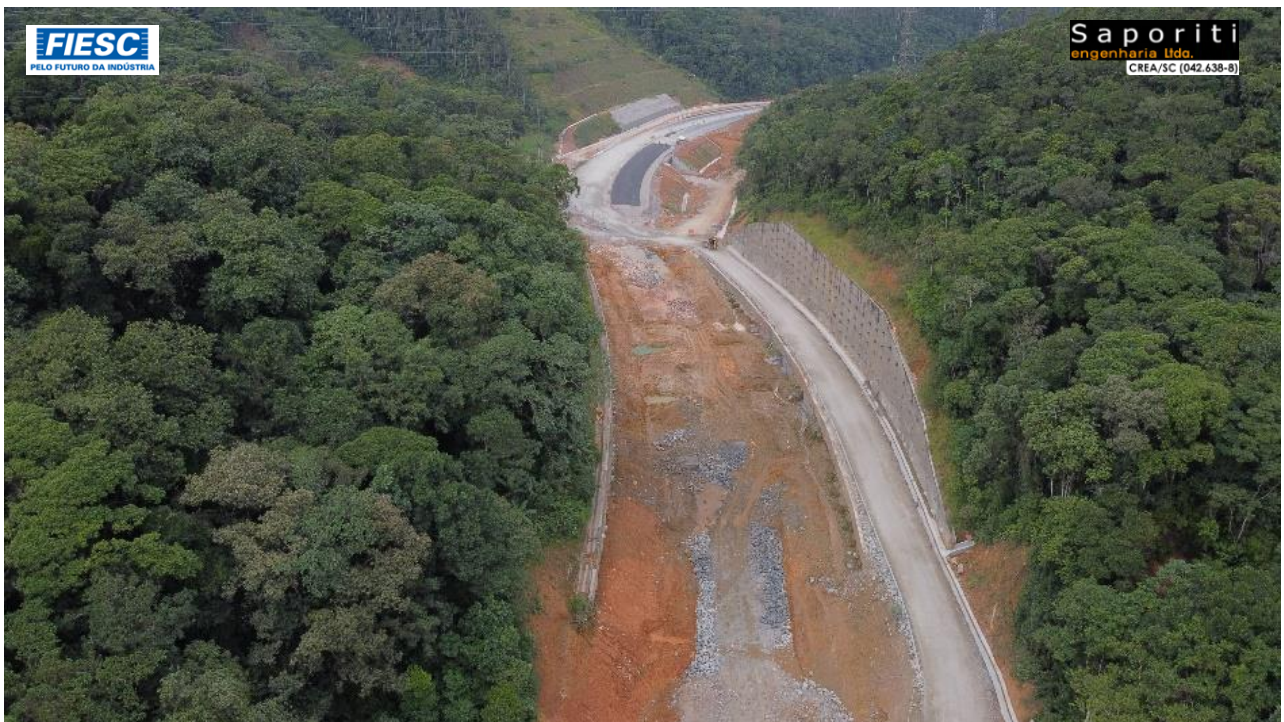
9: CORTE "CAIXÃO" COM PROTEÇÕES DE ENCOSTAS ATIRANTADAS
