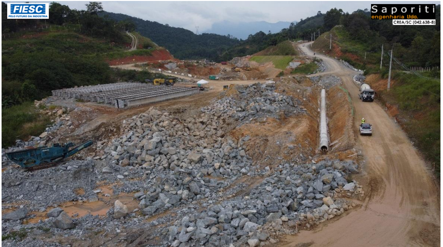
16: VIGAS LONGARINAS FABRICADAS PARA VIADUTOS EM EXECUÇÕES
