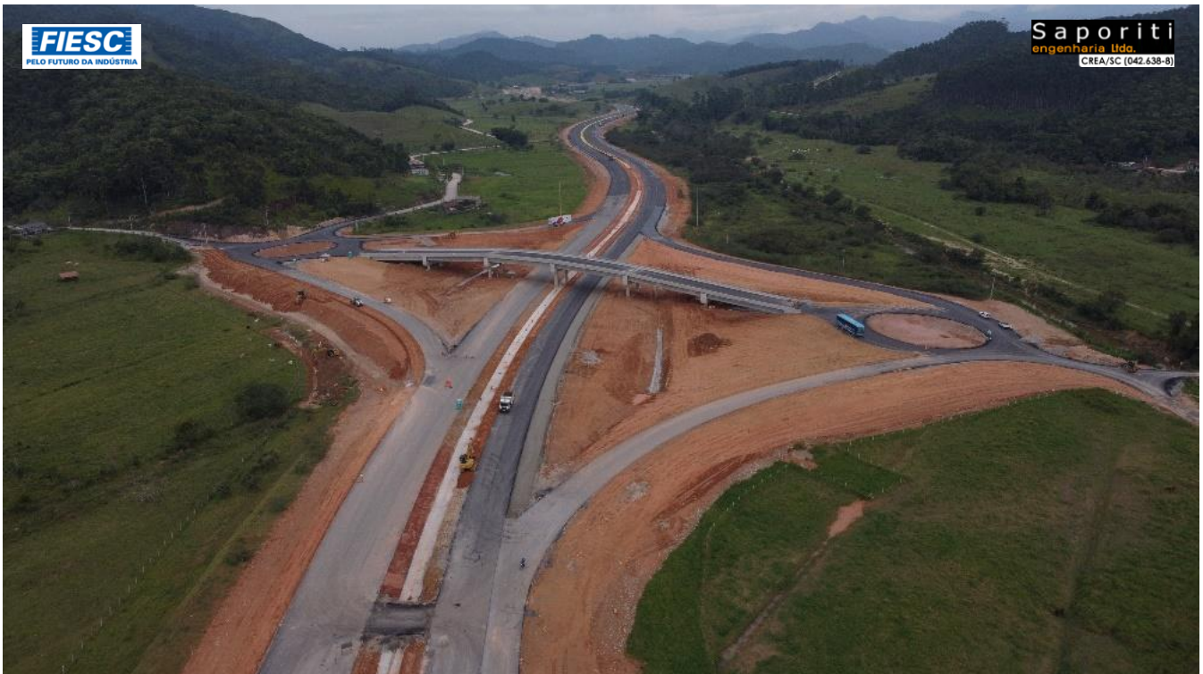
6: PASSAGEM EM DESNÍVEL NA LOCALIDADE DE ESTIVA NO KM 182+500
