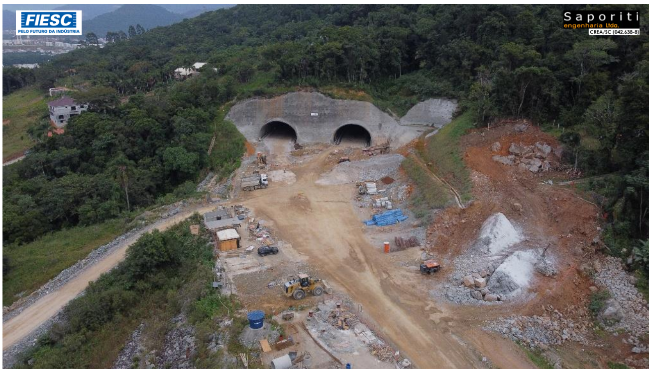
13: EMBOCAMENTO NORTE DO TÚNEL 01 NO KM 220+767 Totalmente concluídas as escavações das frentes de trabalho nas duas pistas
