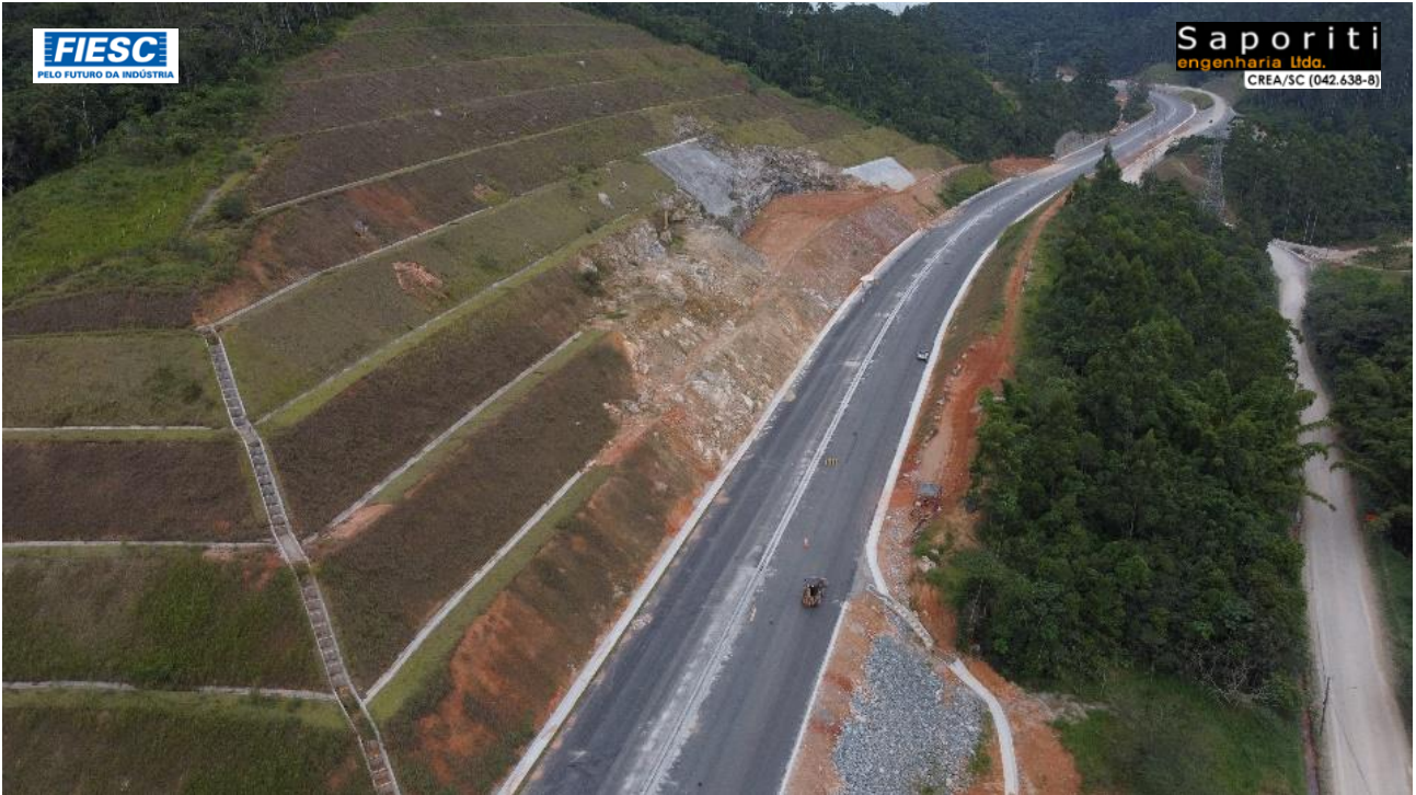
8: OBRAS DE CONTENÇÕES DE ENCOSTAS NO KM 184,8
