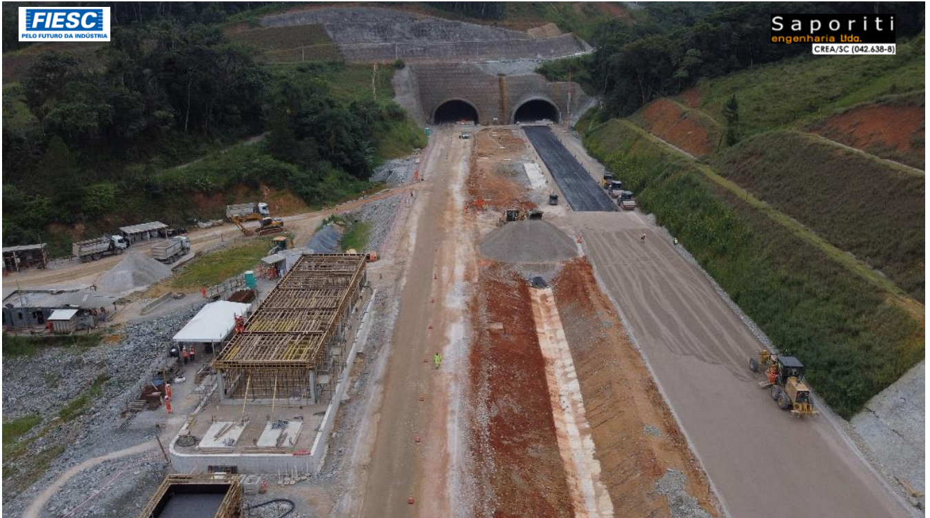
12: EMBOCAMENTO SUL DO TÚNEL 04 NO KM 208+397 Construção da subestação em andamento
