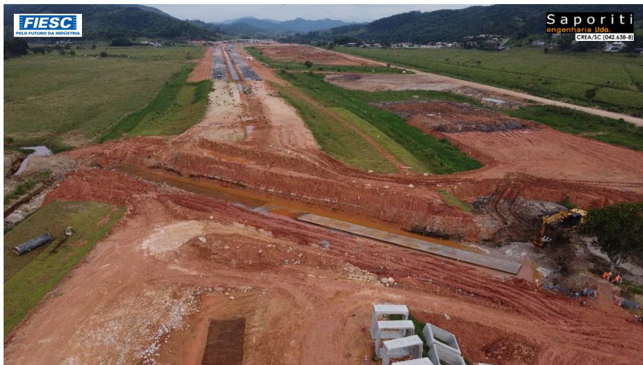
3: OBRA DE ARTE CORRENTE EM EXECUÇÃO NO KM 177+000, bem como terraplenagem no eixo tronco
