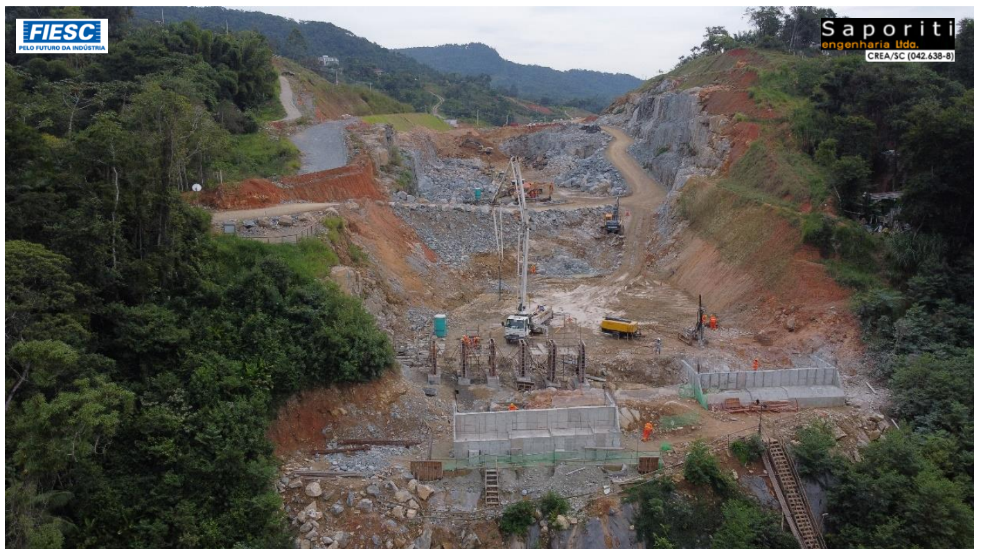
17: CORTE EM ROCHAS NO ACESSO AO TÚNEL 03 NO KM 225 Construção de parte da mesoestrutura do viaduto de acesso ao túnel 03
