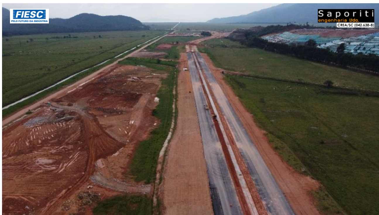
4: PISTAS EM EXECUÇÕES NO KM 179+400
