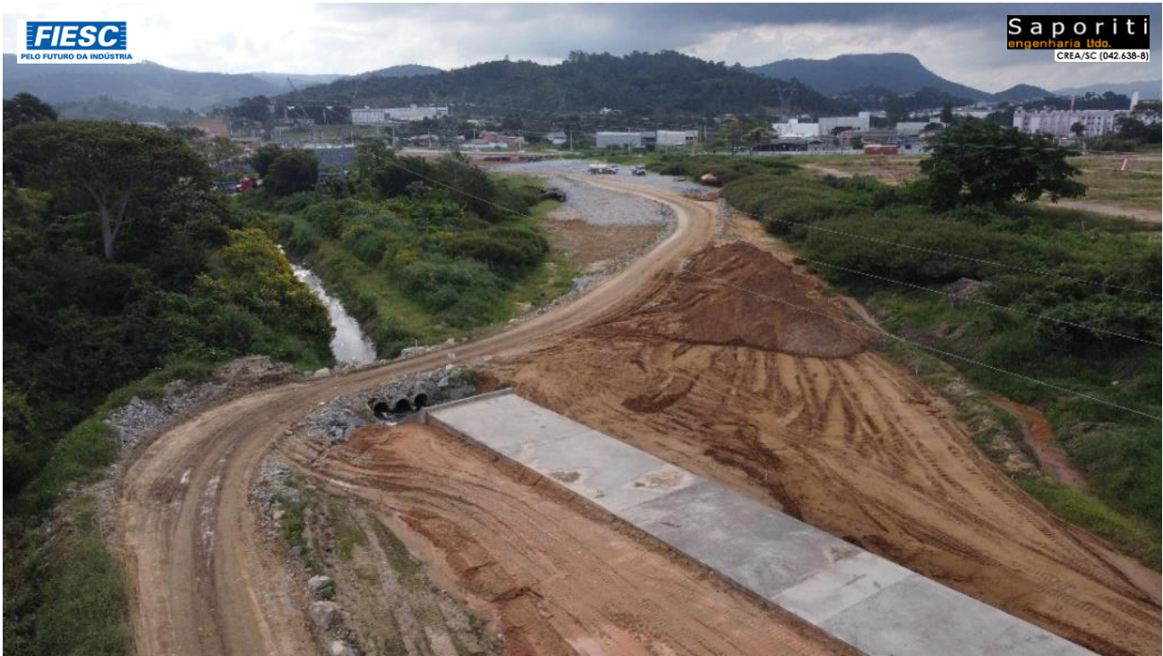
27: CANALIZAÇÃO DO RIACHO ARIRIÚ DE BAIXO NO KM 231+100
