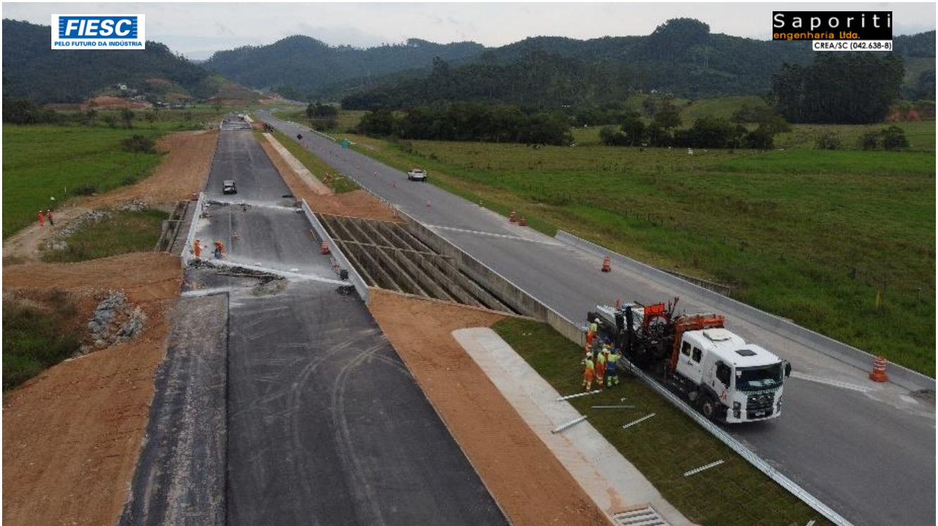
7: OBRAS COMPLEMENTARES EM EXECUÇÃO NO KM 183+300
