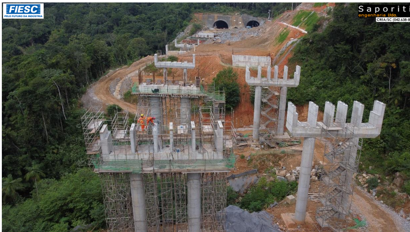
19: EMBOCAMENTO NORTE DO TÚNEL 03 COM ESTRUTURA DO VIADUTO
