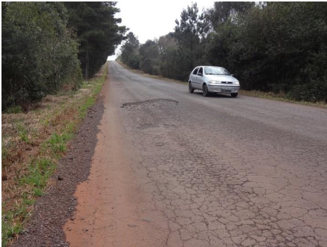
Km 2,8 - Trincamento e desagregação do pavimento
