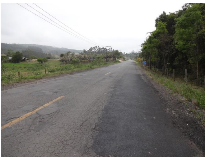
Km 433 - Situação do pavimento
