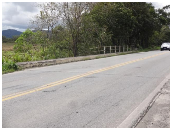
Situação da Ponte s/ Ribeirão das Canas - km 18,8
