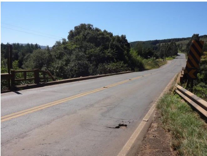
Km 213,5 – Situação da ponte
