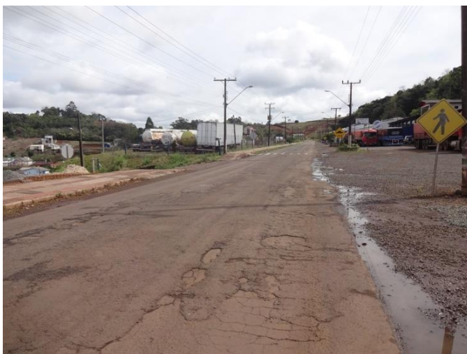
Trecho Palmitos/ Caibi - km 158,5 – Pavimento
