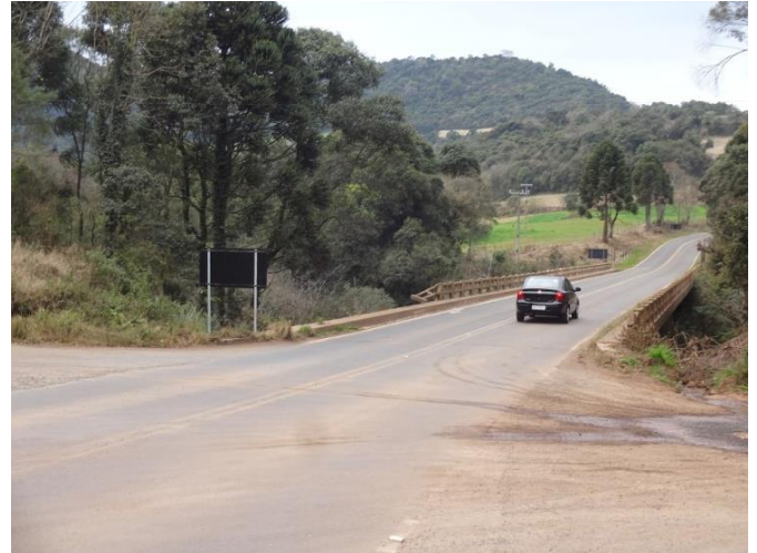
Ponte sobre o Rio Santo Antônio – km 25,0
