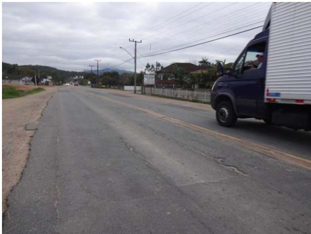
Km 94,0 - Situação do pavimento
