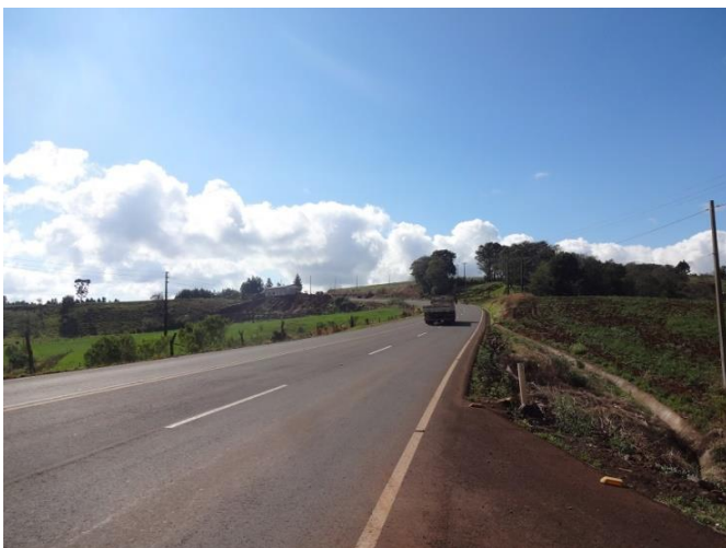
Terceiras faixas - km 16,9
