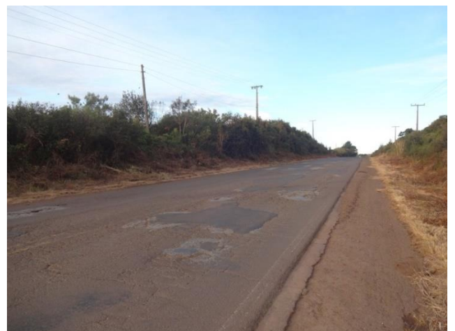
Km 27,3 – Situação do pavimento
