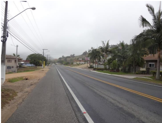
Km 163,5 - Bom estado de Conservação/ Manutenção
