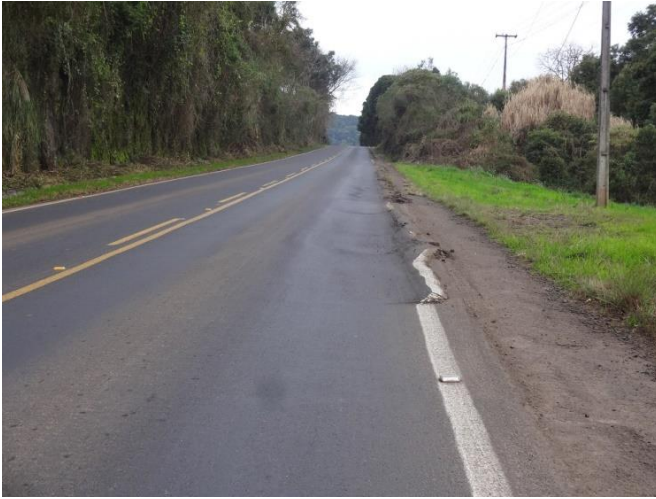
Km 16,4 – Situação do pavimento
