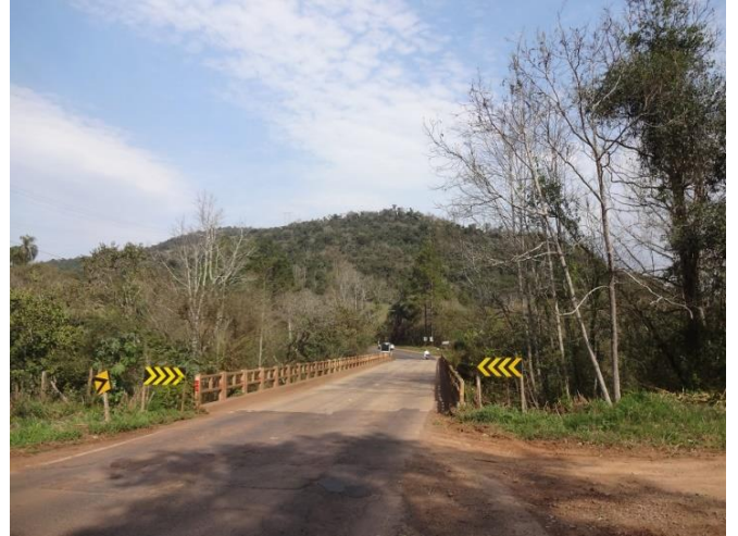
Situação da ponte s/ Rio Ariranha (km 61,8)
