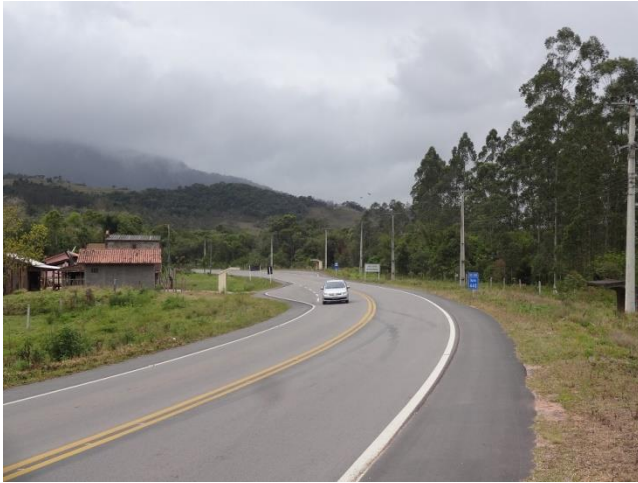
Trecho Orleans/ Pedras Grandes - km 448 - bom estado de Conservação/ Manutenção
