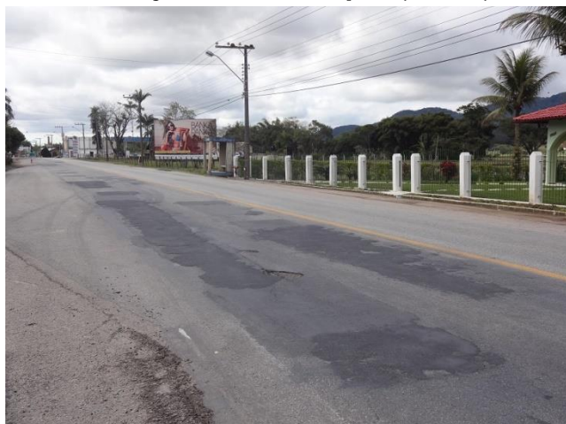
Execuções de "remendos" sobre pavimento danificado
