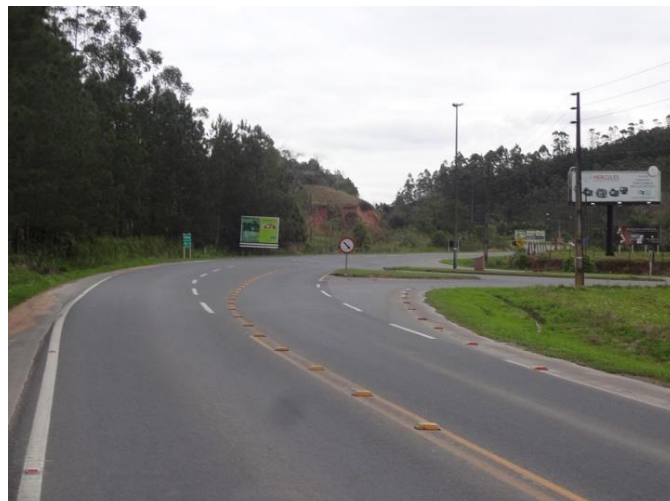
Entroncamento para Rio dos Cedros (km 117)
