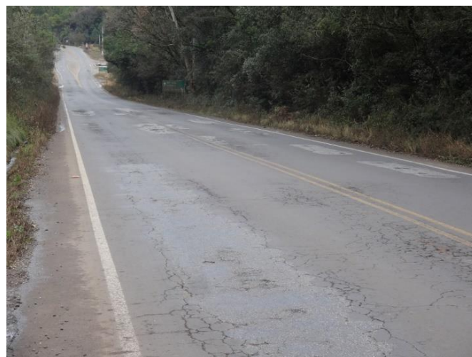
Km 115,8 – Situação do pavimento
