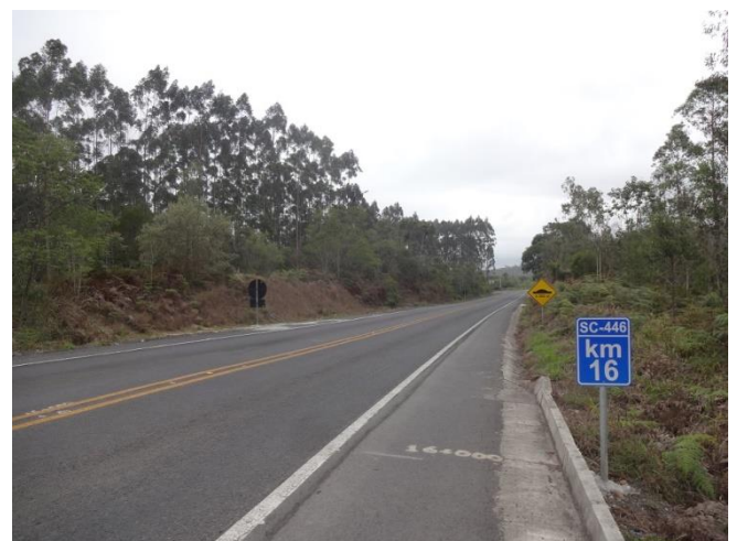
Trecho Treviso/ Siderópolis- km 16 - Recém implantado
