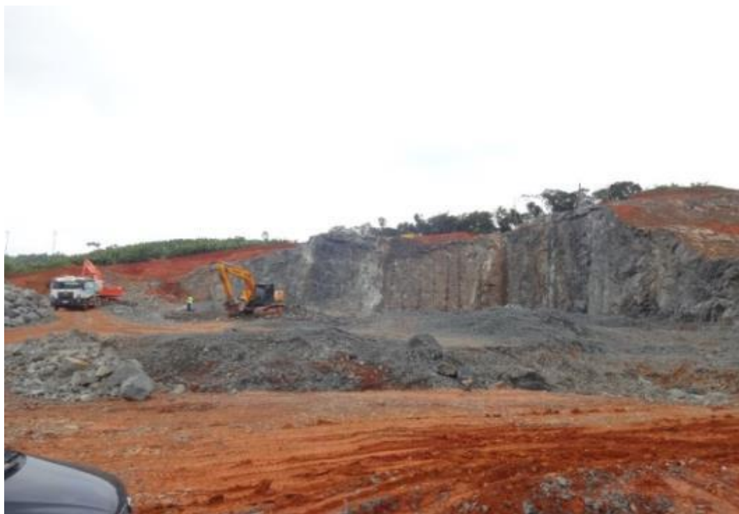
Figura 10: Preparo das instalações da central de britagem e da futura usina de asfalto.
