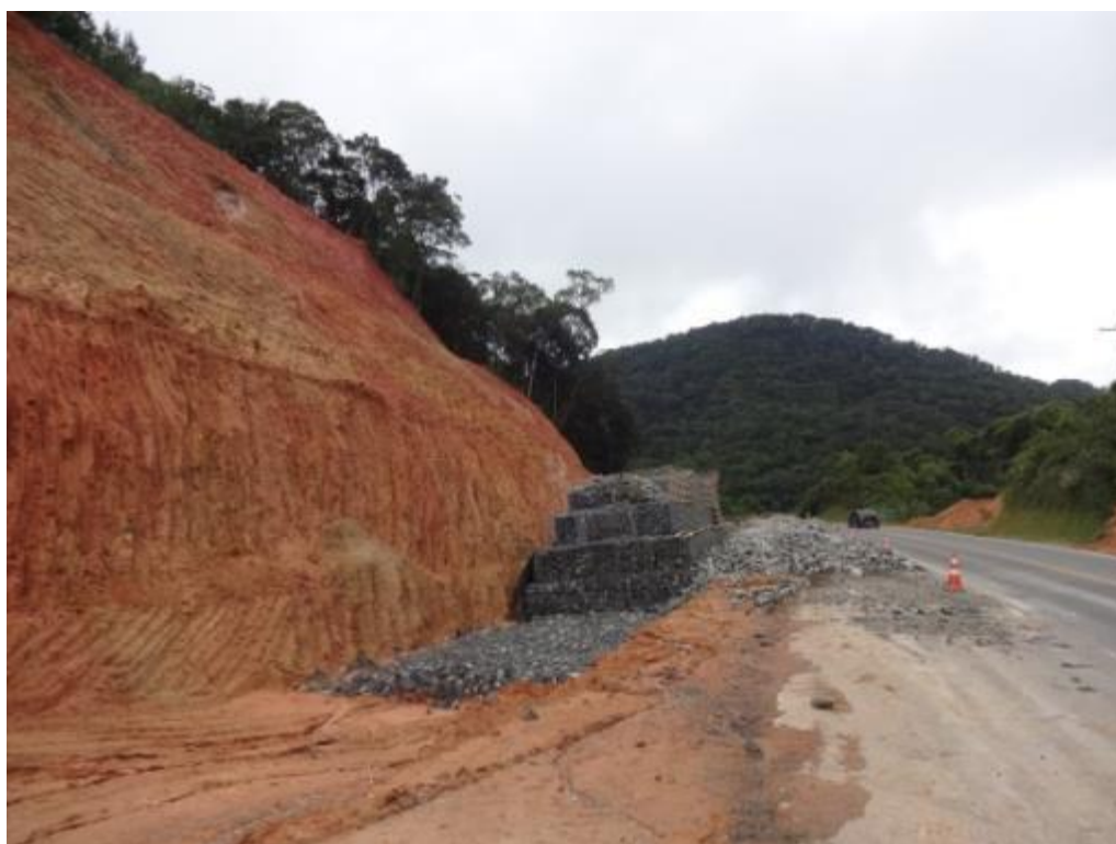
Figura 24: Contenção em execução no km 106,0
