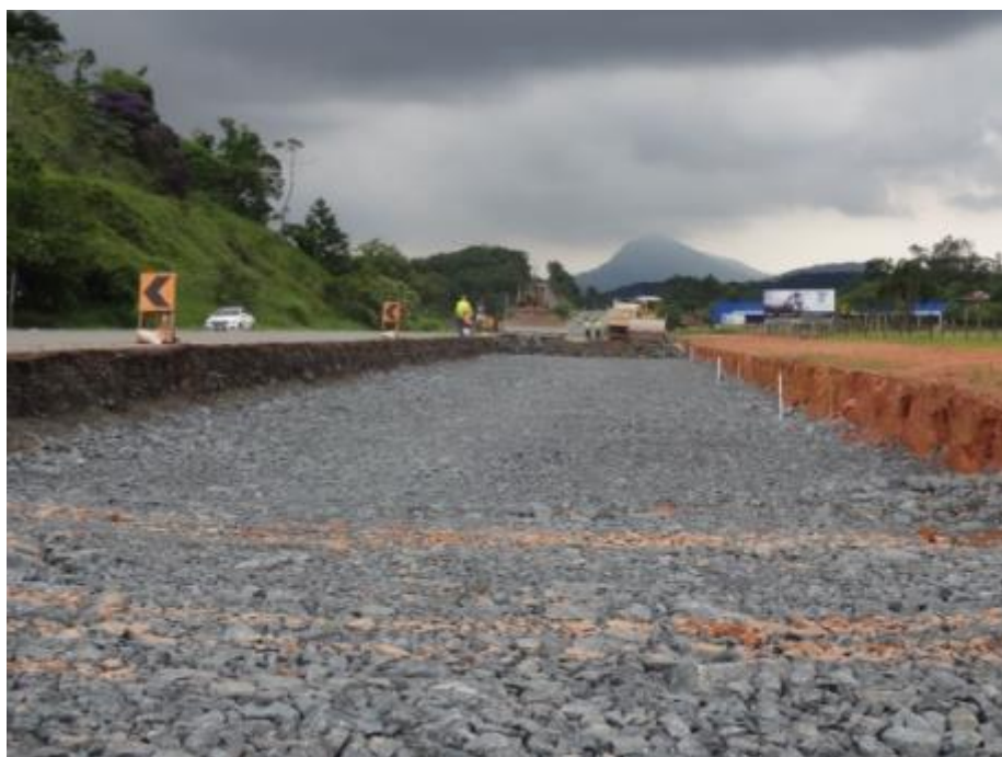
Figura 12: Km 45,5 - Execução da base da nova pista
