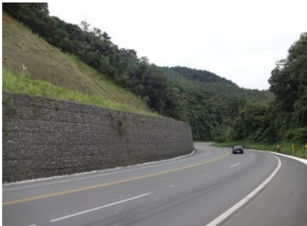
Figura 22: Muros de contenções - km 95,0
