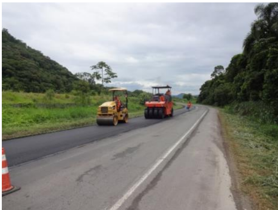
Figura 19: Outra vista da recuperação do pavimento
