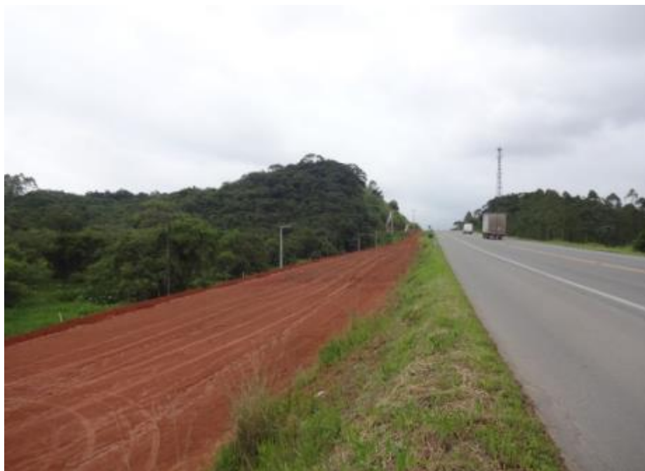
Figura 11: Terraplenagem- Nova pista.... km 47,7
