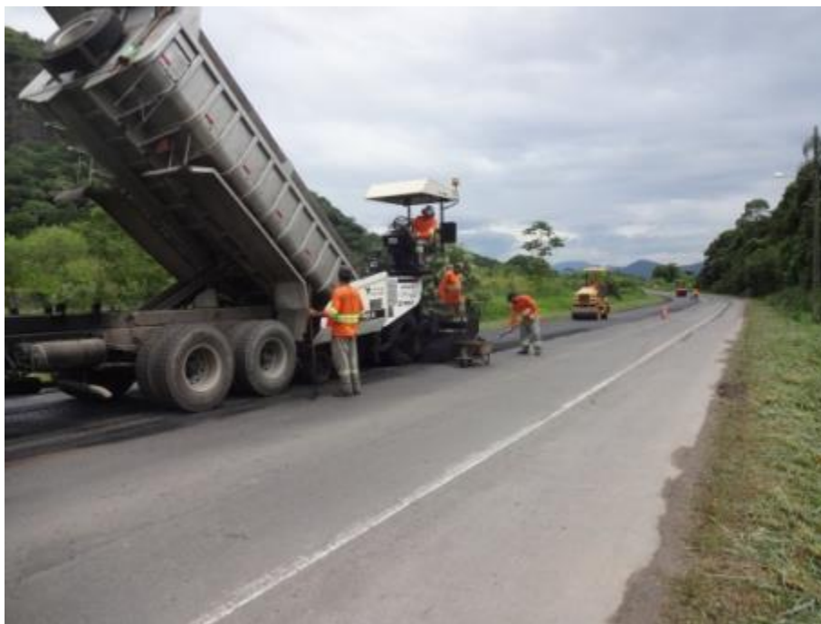
Figura 18: km 1,8 - Execução de nova capa asfáltica
