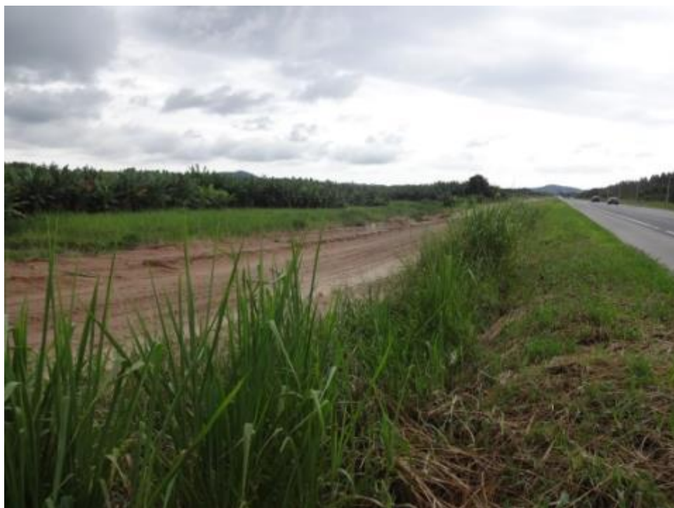
Figura 14: Execução de colchão drenante - km 41 ao 44
