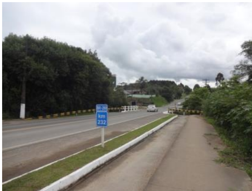
Figura 28: Início do trecho "federalizado", em Canoinhas - km 232,0
