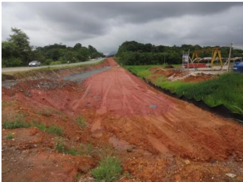
Figura 13: Km 44,6 - Terraplenagem sobre geotêxtil
