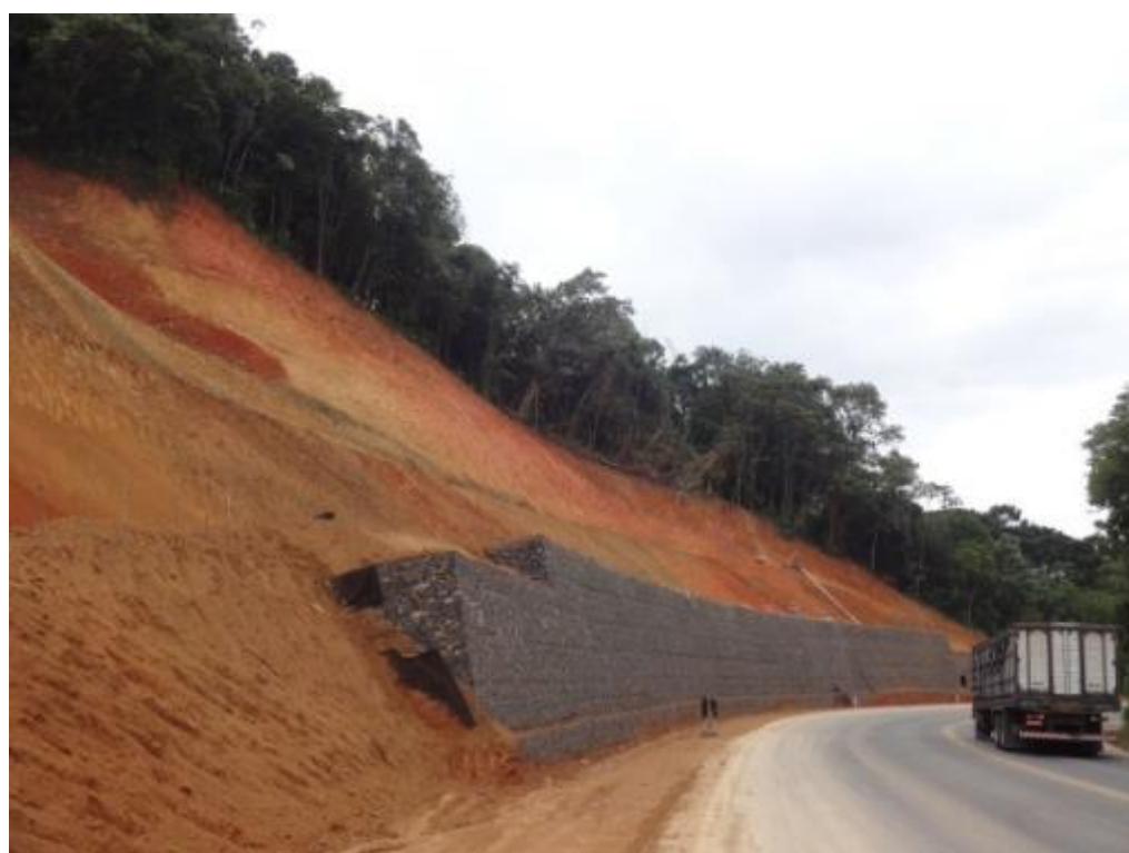
Figura 23: km 104,5 - Muros de contenções e enlevamento de taludes
