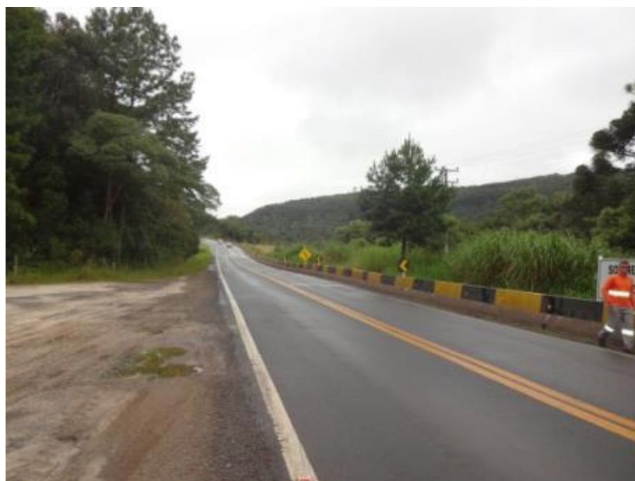
Figura 29: km 297,0 - Trecho em obras
