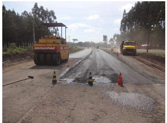
Figura 21: km 3 - Obras recuperação - Contrato DEINFRA
